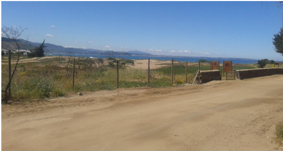
Figura 11. Pirca y portón de entrada de las Dunas de Cachagua
